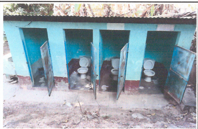
Foto 4: Mejoramiento de Servicios sanitarios y sus accesorios de los cuatro baños de la escuela.
