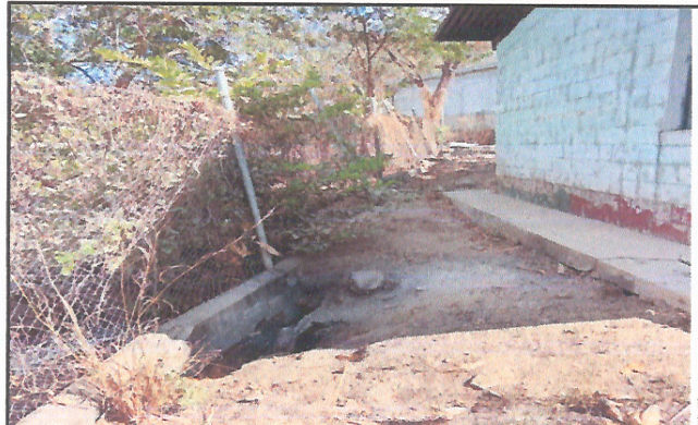
Foto 2: Mejoramiento de Reparación de muros de contención.
