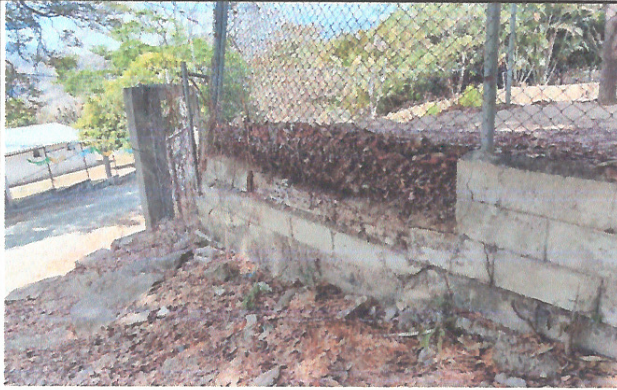
Foto 1: Mejoramiento de Reparación de muros de contención.
