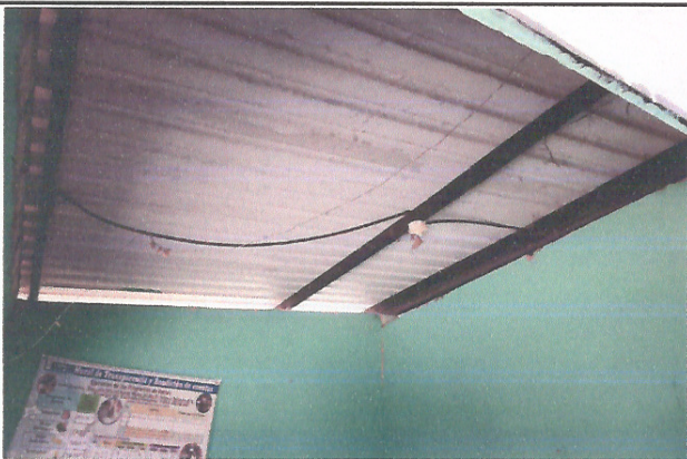
Foto 3: Mejoramiento de Reparación de sistema eléctrico de toda la escuela.
